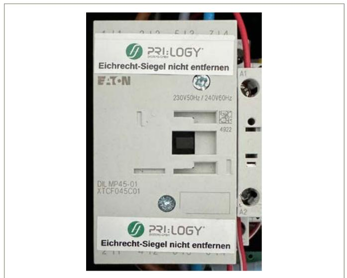
Ebenso die Kabel, die zur Ladesteckdose führen sowie die dazugehörigen Kontakte bzw. Klemmen an der Ladesteckdose. Die Schraubkontakte werden mit einer Kappe abgedeckt und auf einer gegenüberliegenden Seiten mit einem Herstelleraufkleber versehen.
